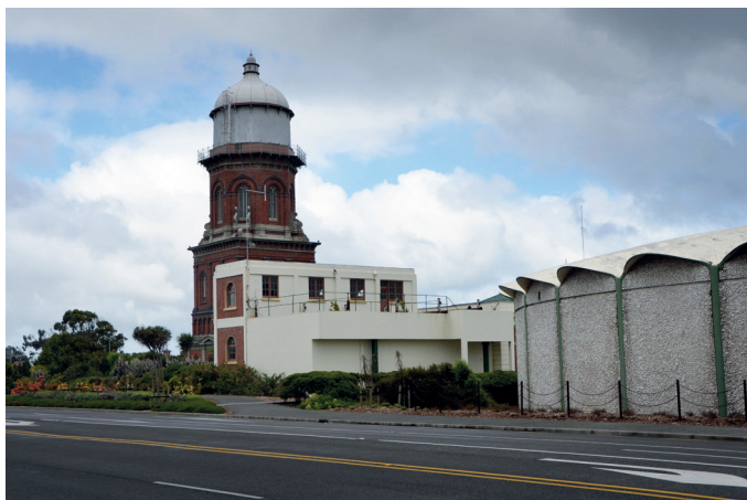
Obr. 17 Vodárenská věž v Invercargill
