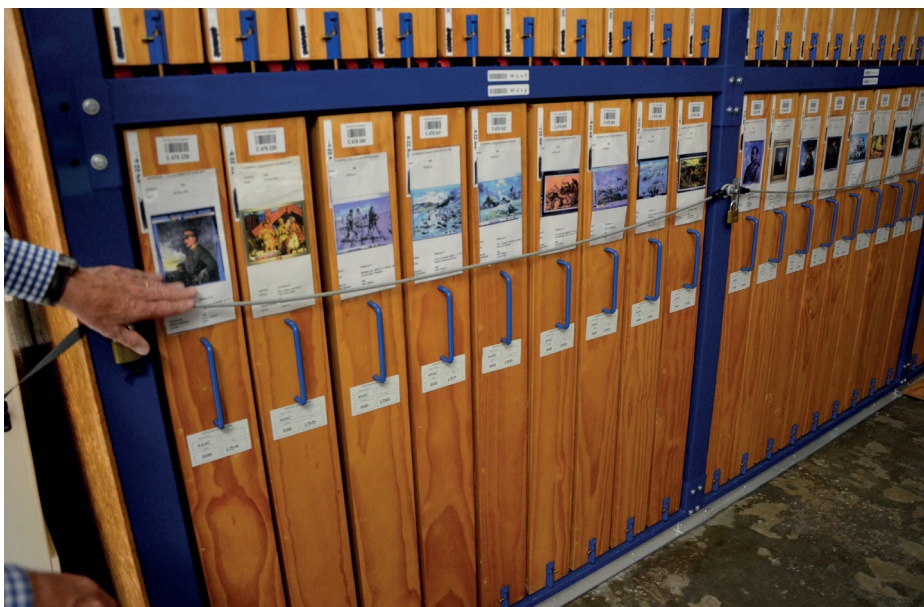
Obr. 37 Ukázka ochrany fondů při zemětřesení
