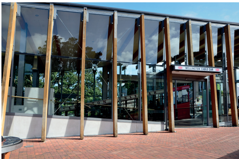
Obr. 42 Terminál pozemní lanové dráhy ve Wellingtonu
