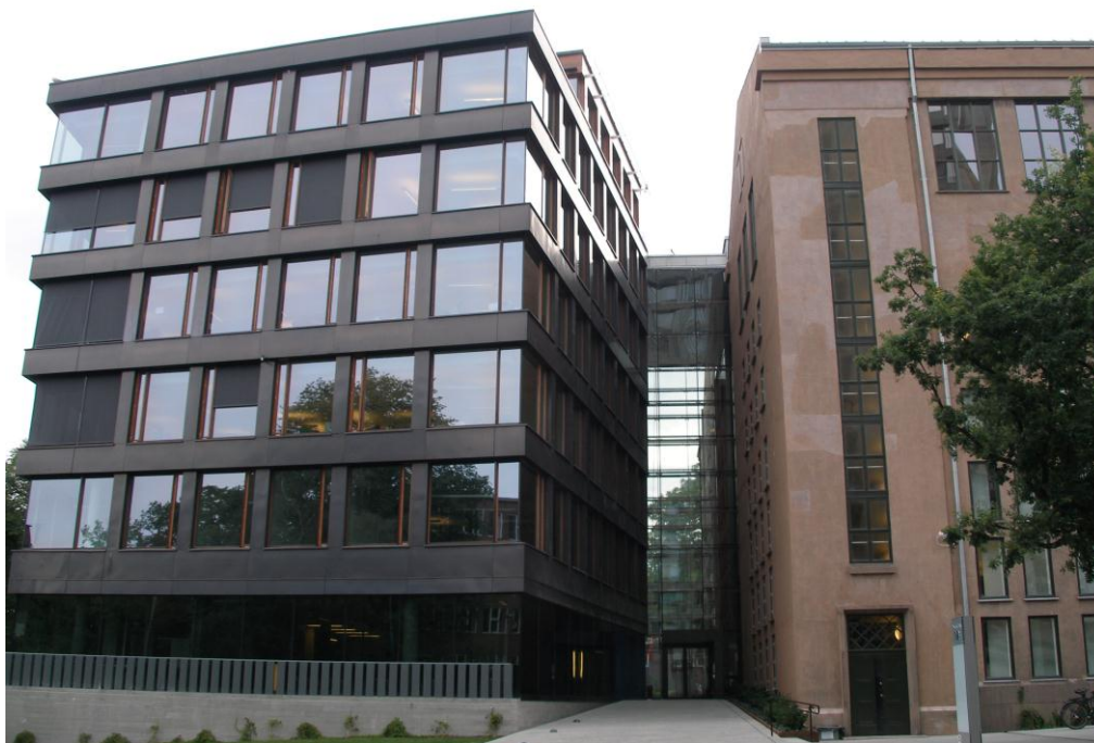
Obr. 13: Přístavby za historickou budovou NK Norska
