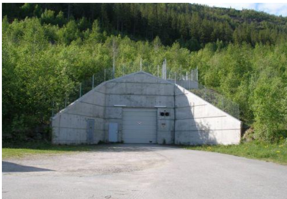
Obr. 2: Vchod do skalního masivu
