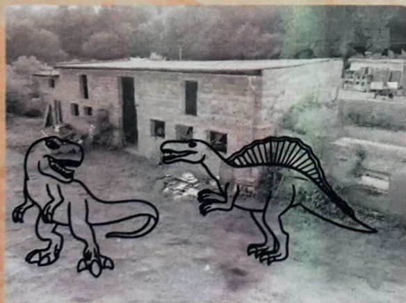
Škola před rekonstrukcí
