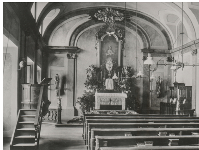
Klementinská kaple Srdce Pána Ježíše, která zanikla při Machoňově přestavbě, kdy byla přebudována na skladiště. V té době byla nazývána Fantova kaple a skladu se dodnes říká „Fantovka“.
